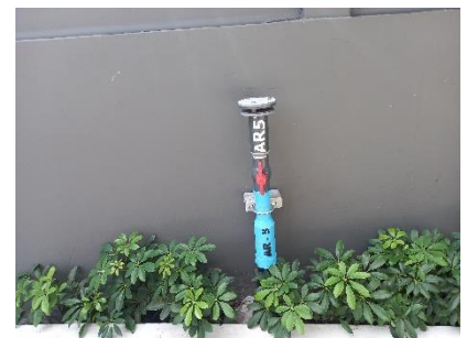
ท่อเติมอากาศระบบบำบัดน้ำ
